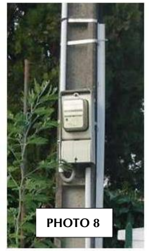
Compteur extérieur apparent
